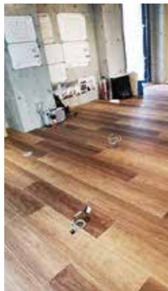
画像① 現状風景 (施工途中)
